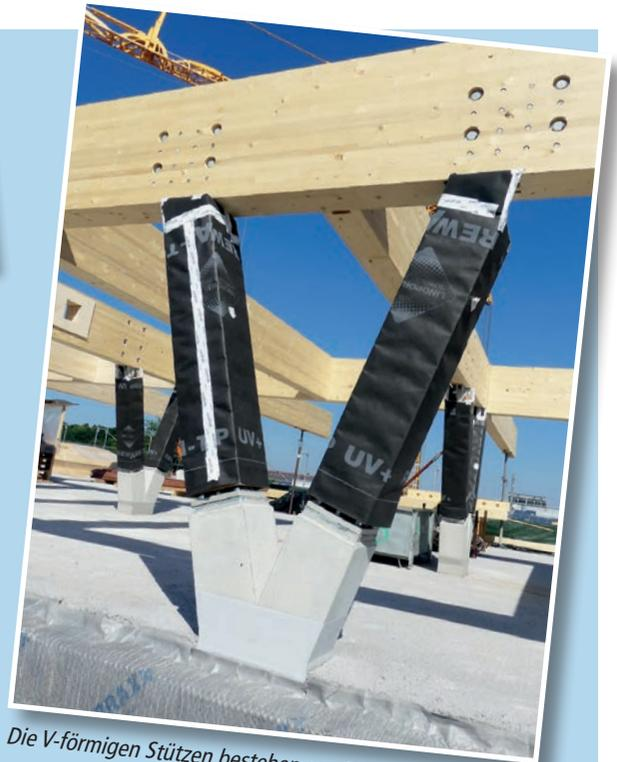
Die V-förmigen Stützen bestehen aus Holz und Stahlbeton.
