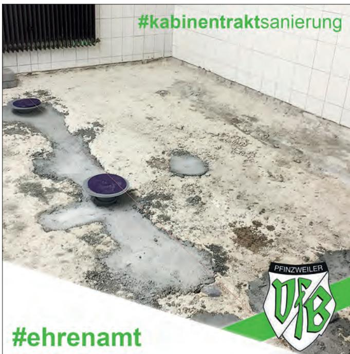
Der Duschbereich wurde komplett ehrenamtlich entkernt und die Abwasserrohre neu verlegt.
