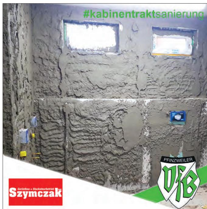
Durch die Firma Szymczak wurden Sanitärbereich und Schiedsrichterkabine in kürzester Zeit verputzt.
