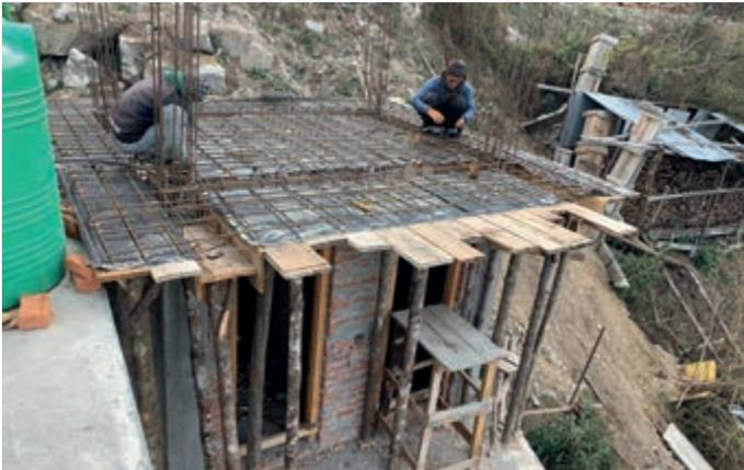
Auf dem Bild sieht man auf dem Dach des zweiten Stockwerkes noch die metallene Armierung. Mittlerweile ist der Estrich gegossen und muss nun trocknen. Der Wassertank befindet sich auf dem Hauptgebäude. Die Solaranlage soll dann direkt auf dem Neubau angebracht werden. Zum Trocknen werden rund 20 Tage veranschlagt.
